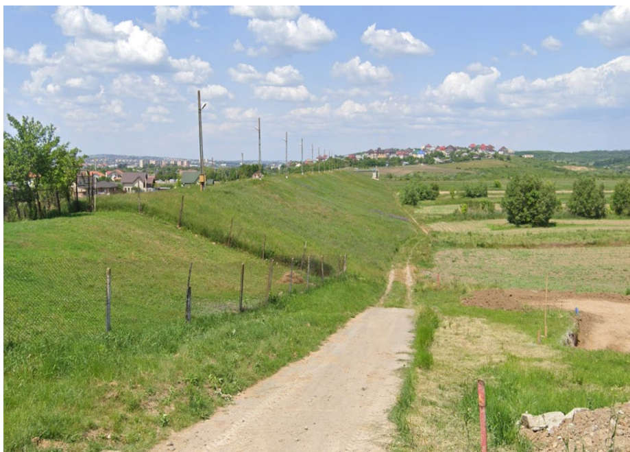
Figura 4 – Dig de pământ în lunca Nicolinei (Strada Ecoului)
